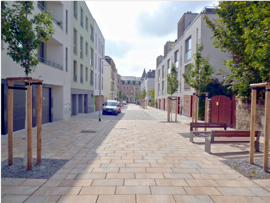
Quelle: STESAD GmbH, Ausbau der Kiefernstraße im Sanierungsgebiet – Dresden Hechtviertel
