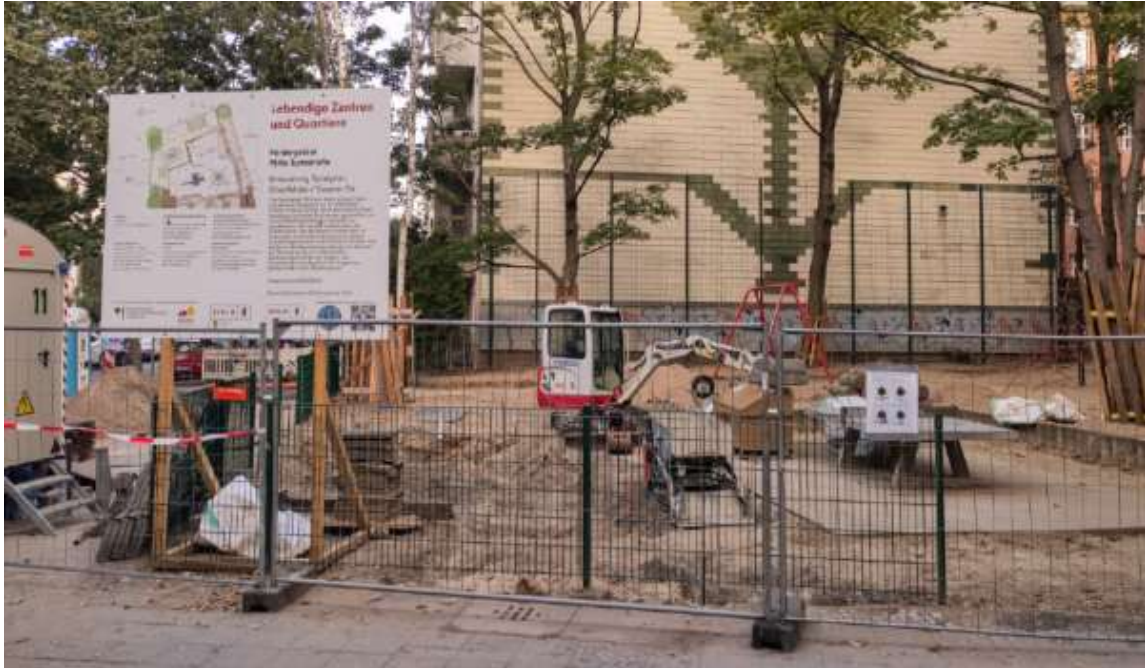
Bauarbeiten auf dem Spielplatz Elberfelder Straße/Essener Straße
