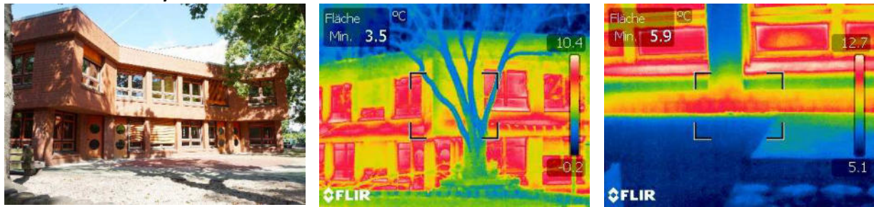
Thermografieaufnahmen der Front, Detail Geschossdecke und Bodenplatte
