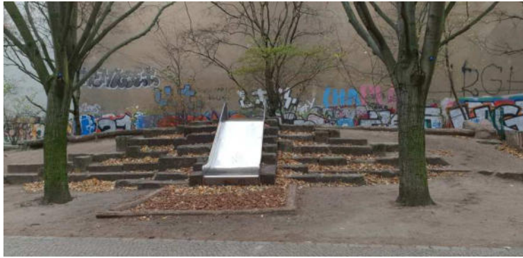
Rutsche eingefasst mit Charlottenburger Gehwegplatten
