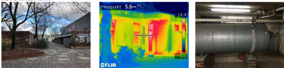
Eingangsbereich Revierunterkunft, Trinkwarmwasserspeicher
