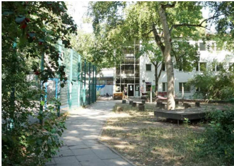
Wolfgang-Scheunemann-Haus mit Vorplatz
