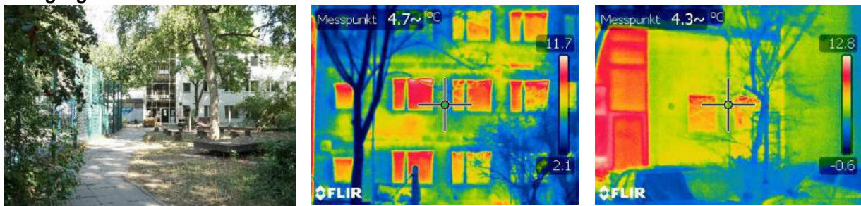
Ansicht des Wolfgang-Scheunemann-Hauses, Thermografieaufnahmen Wohn- und Veranstaltungsgebäude
