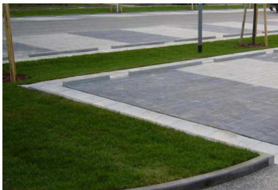
Beispiel einer Parkflächenentwässerung
