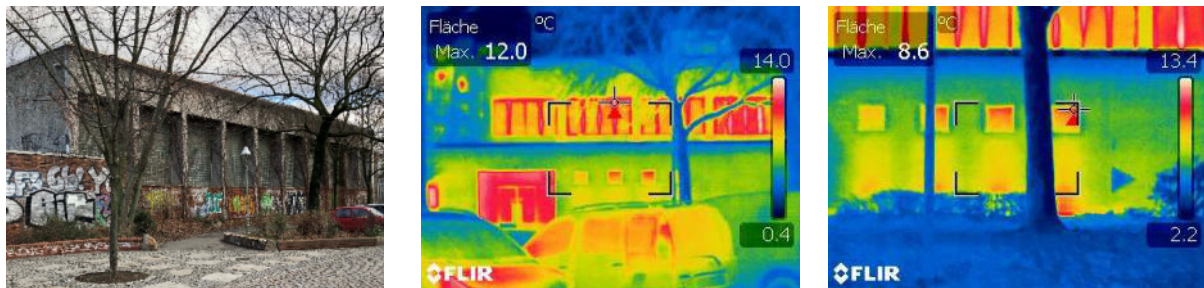
Frontansicht der Sporthalle, Thermografieaufnahme Vorgebäude
